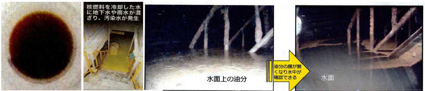
(資料4) 左から「原子炉建屋汚染水」「高温焼却炉建屋汚染水」「3号機タービン建屋」油分改修前と回収後の画像
