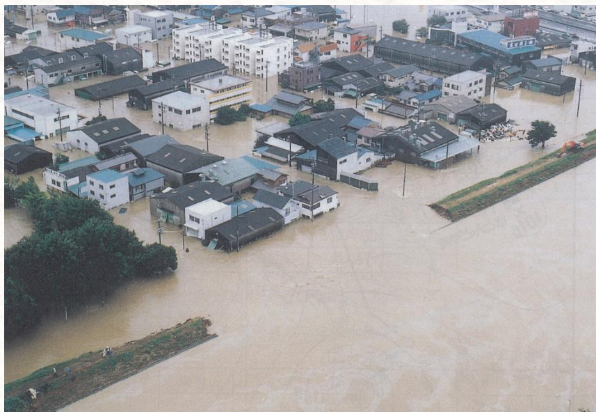
新川の堤防決壊箇所 (名古屋市西区あし原町)
